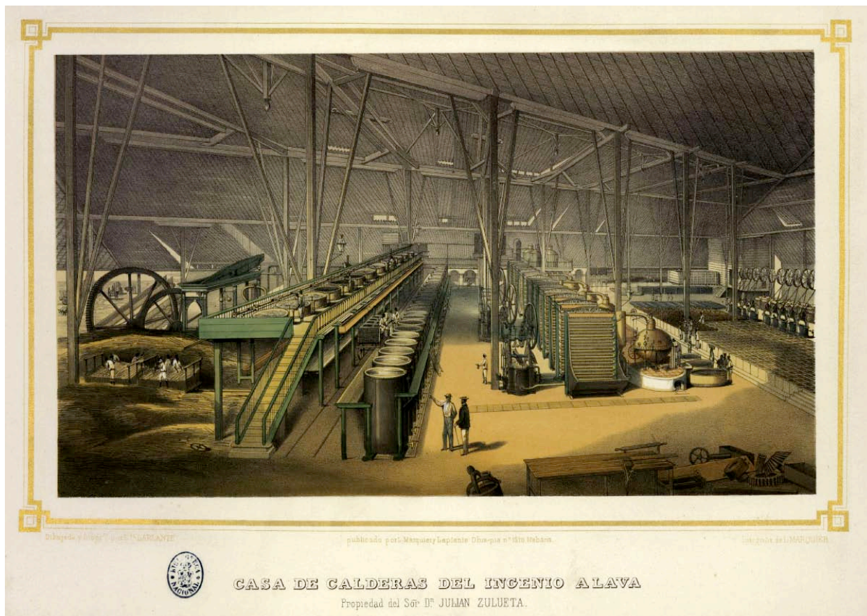
Installations industrielles de l' ingenio Álava (500 esclaves), près de Banaguises, province de Matanzas, vers 1850.
