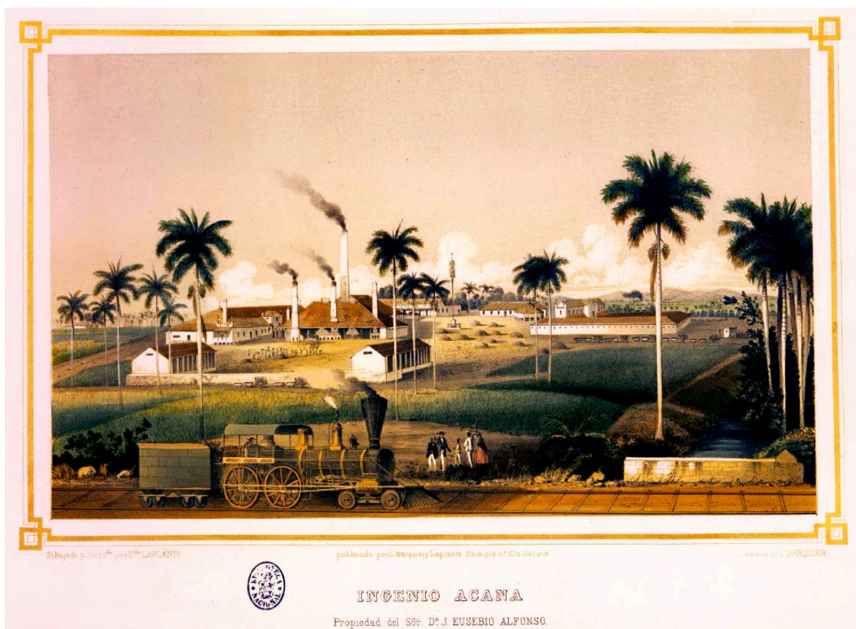
Installations industrielles de l' ingenio Ácana (360 esclaves), à Cidra, Matanzas, vers 1850.
