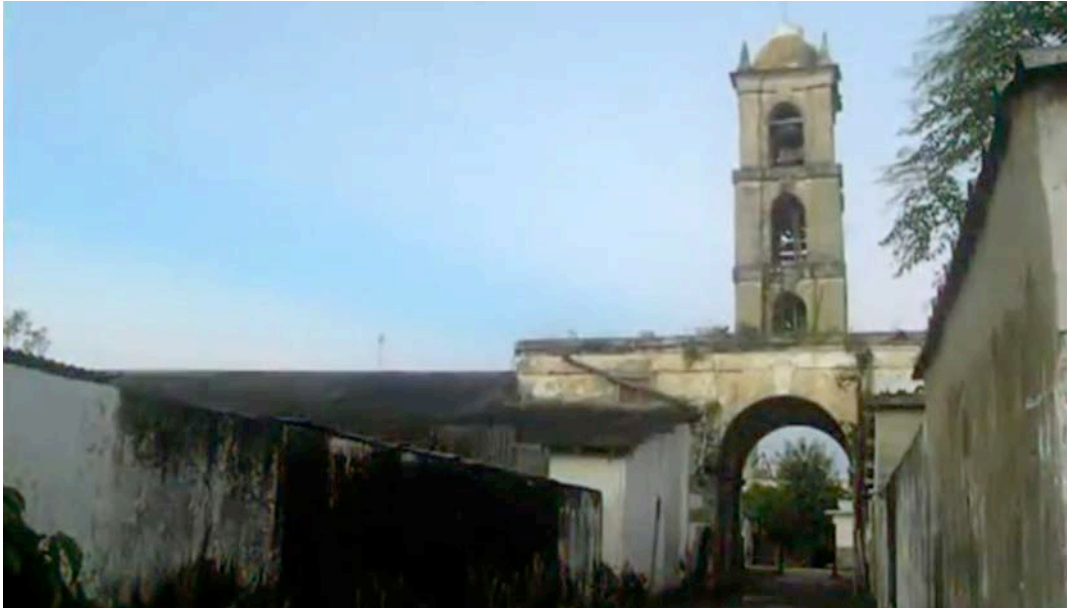
Campanario de l'ingenio Álava et entrée du barracón des esclaves. Les maisons et les murs qui s'appuient sur le campanario furent construits postérieurement.
